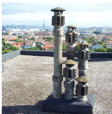
Figure 2 : Conduit individuel ou collectif visible sur le toit (voir détails figure 3).
