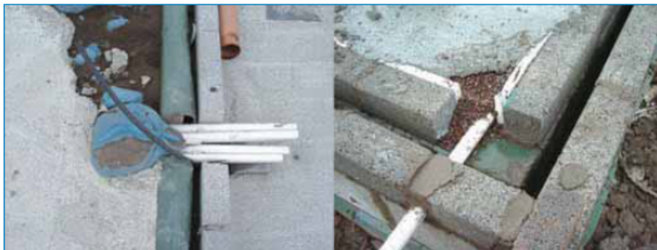
Drainage du radon par mise en dépression du sol sous-jacent au bâtiment.
